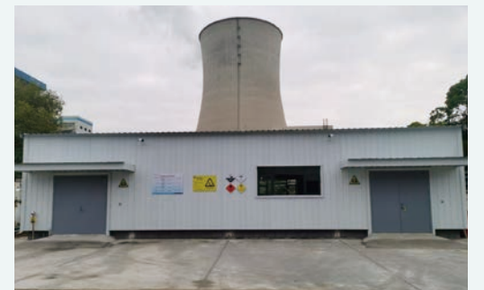
安徽华电宿州发电有限公司扩建危废库
