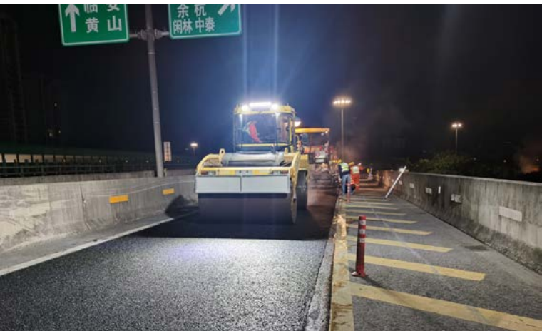
杭州北管理中心夜間斷流集約化施工現場
