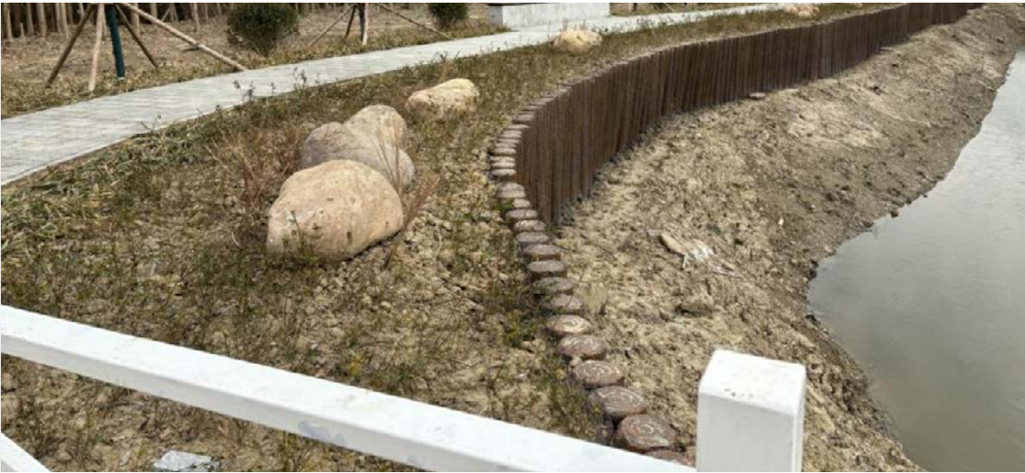
王店互通區域駁岸加固後
