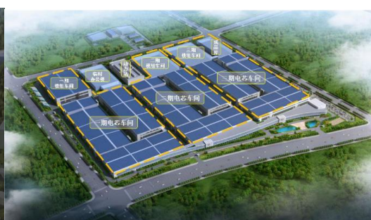
镇江生产基地（三期建设中）
